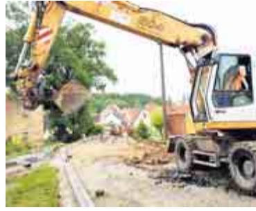
Bauarbeiten in Belleben.
